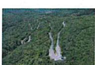
Modernizarea drumului judetean DJ 107 Transalpin Apuseni 1.JPG
