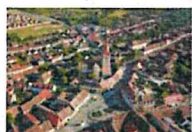
Lucrari de reparatii, conservare si introducerea in circuitul turistic la Ansamblul Bisericii Evanghelice Fortificate din Gradiste.JPG
