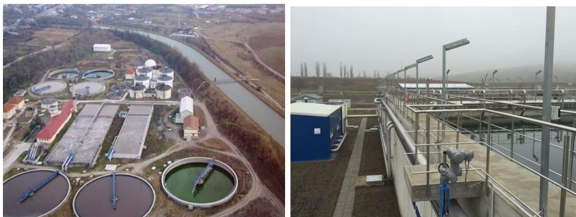
Figura 4.3.2 Stațiile de epurare a apei din Alba Iulia (stânga) și Tîrgu Mureș (dreapta)
