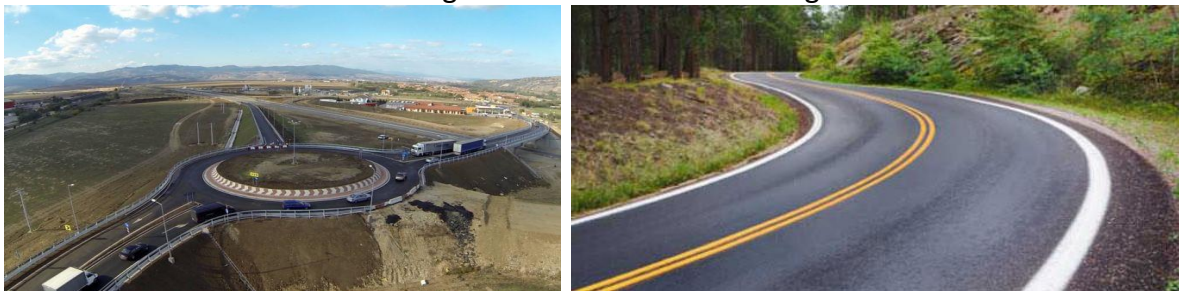
Figura 3.1.4 Autostrada în zona municipiului Sebeș (Foto: adevarul.ro 16 , 2013), Figura 3.1.5 Modernizare DJ 151B și DJ 142, între Ungheni și Târnăveni din județul Mureș (Foto: t-times.ro 17 , 2018)
